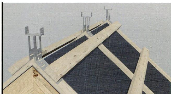
Je treba namontovať laty. Vzdialenosť lát závisí na používanom modeli škrídly. Montáž lát začíname od odkvapu. Podhrebeňovú latu je treba upevniť vo vzdialosti 3,5-4,5 cm od vrcholu strechy.
